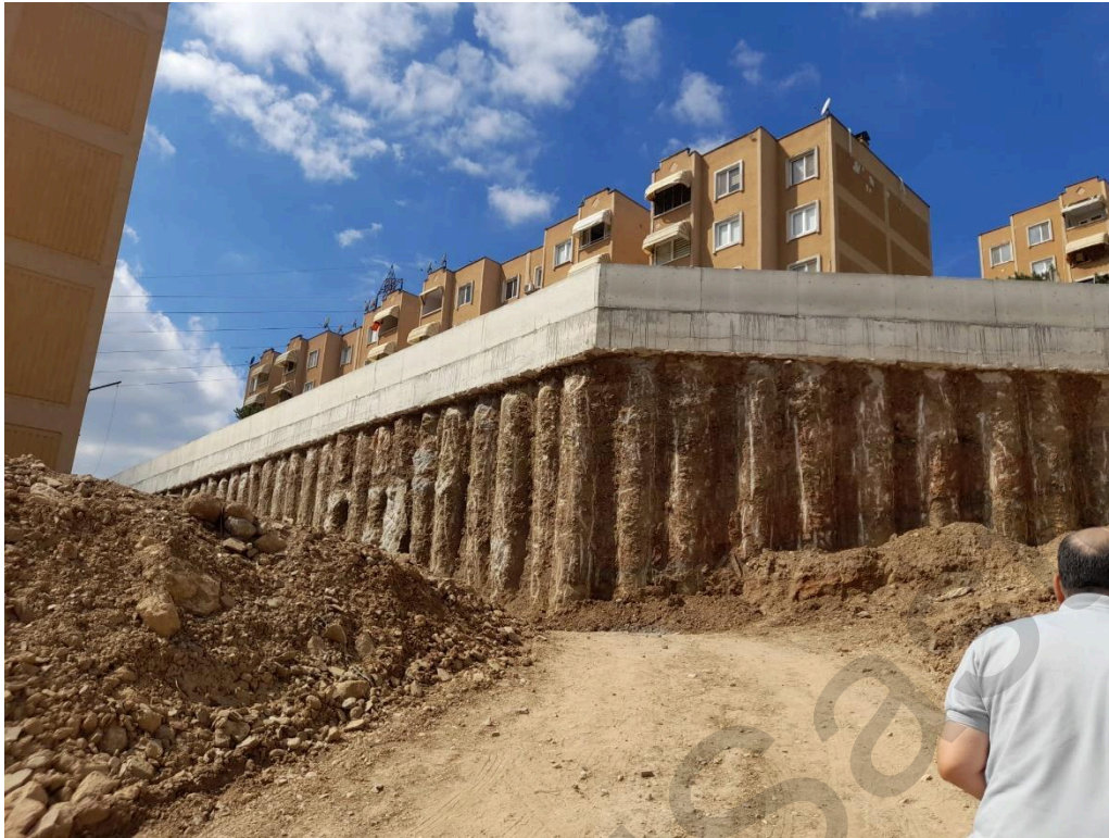
Figura 3.20. Muro di contenimento di recente costruzione.
